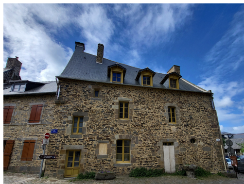
Maison de la Trésorerie, rue Ceinte
