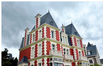
Rose des Vents, Digue du Sillon
