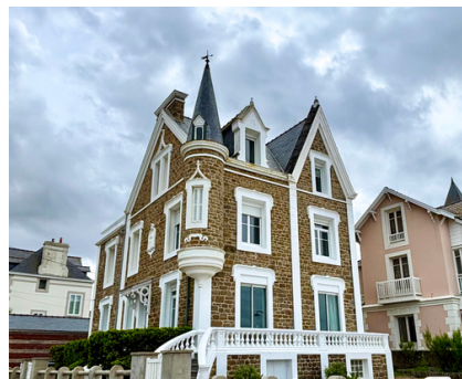
Castel Marie, Digue du Sillon
