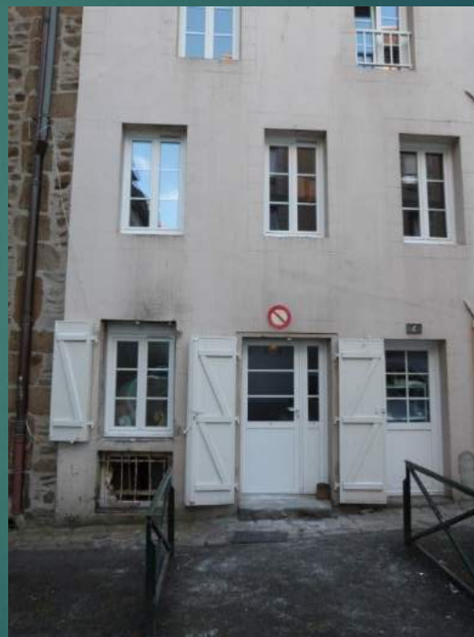
Arrière de la boulangerie, rue Robert-Surcouf
